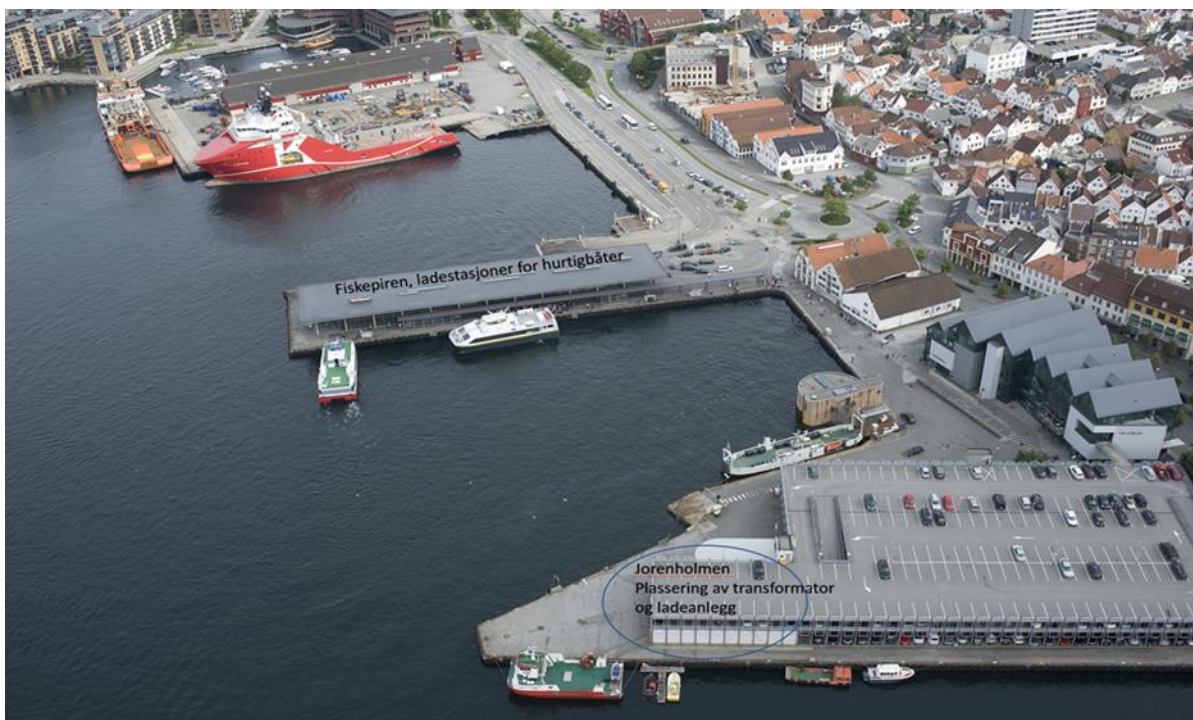
Figur 3 Plassering av transformator og ladeanlegg
