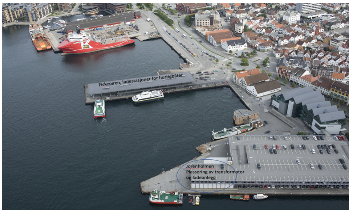
Figur 1 Plassering av transformator og ladeanlegg
