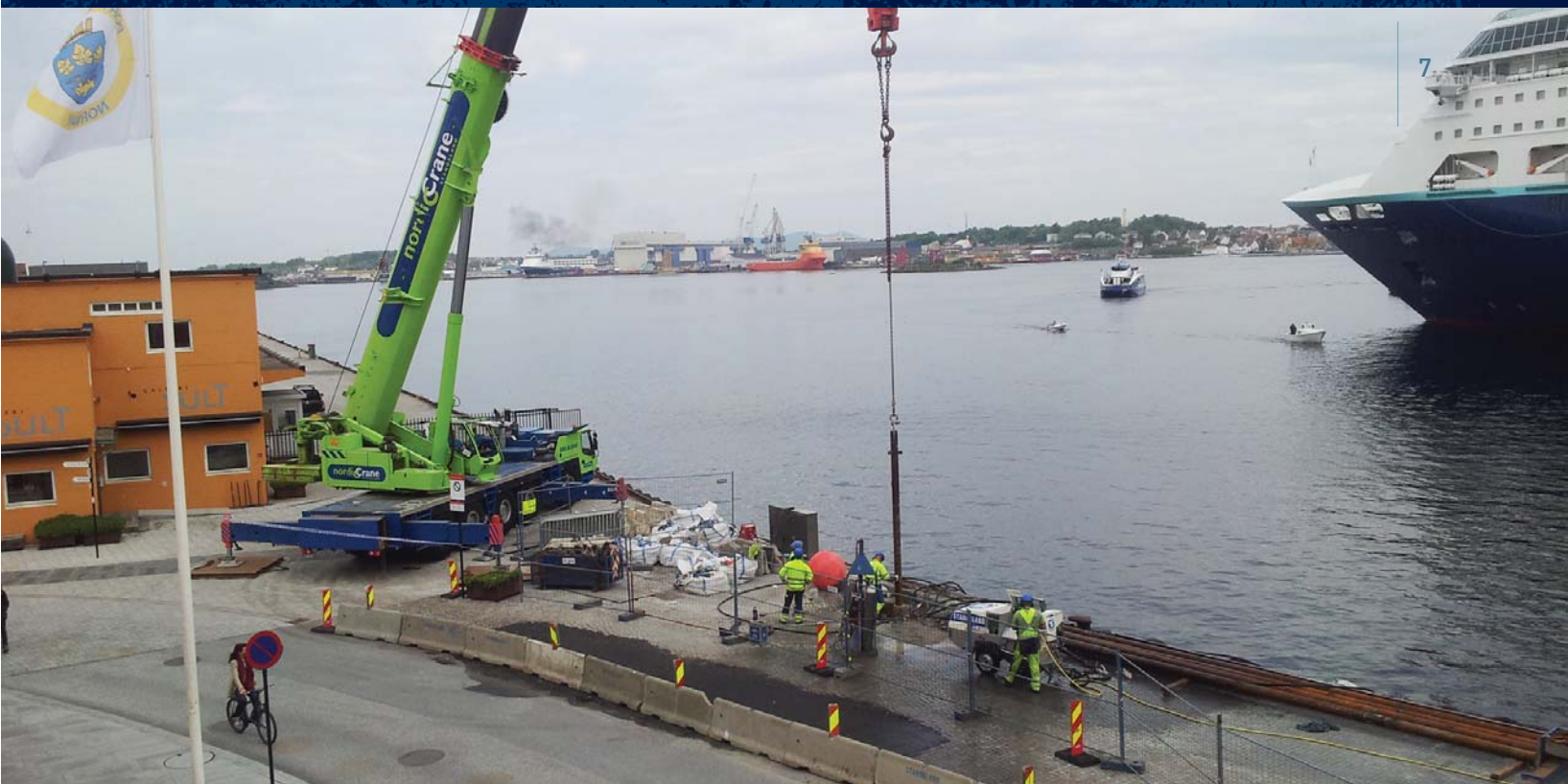
Pullert-arbeid på Strandkaiaen (Foto: O. B. Bekkeheien)
